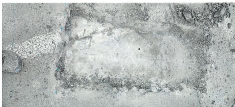
Obr. 16: Sekaná sonda SS3 přes vozovkové souvrství parkoviště 2. NP. Z povrchu vozovky je odstraněná vrstva asfaltobetonu. V obnažené vrstvě drátkobetonu je viditelný prořez smršťovací spáry – zdroj zatékání vody do stropní konstrukce parkoviště.
