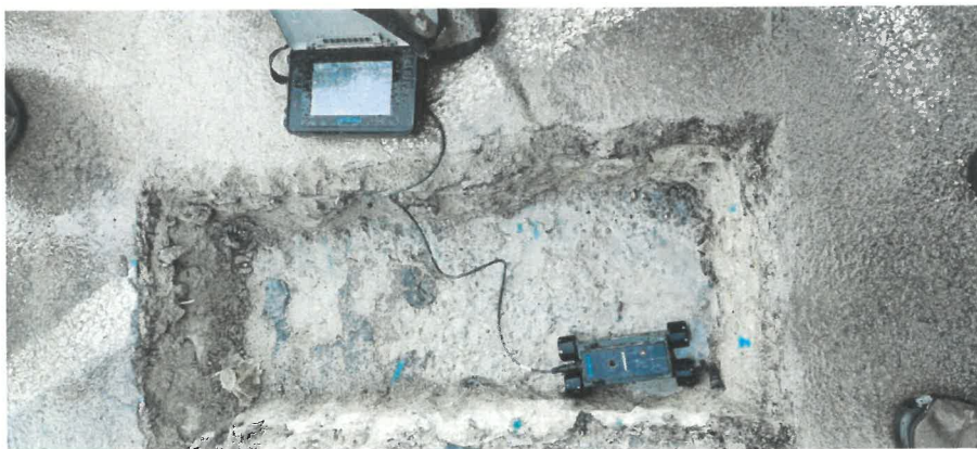
Obr. 17: Sekaná sonda SS3 přes vozovkové souvrství parkoviště 2. NP. Z povrchu vozovky je odstraněná vrstva asfaltobetonu a drátkobetonu. Na obnaženém povrchu nosné konstrukce stropní desky byly nedestruktivně lokalizovány pruty výztuže.
