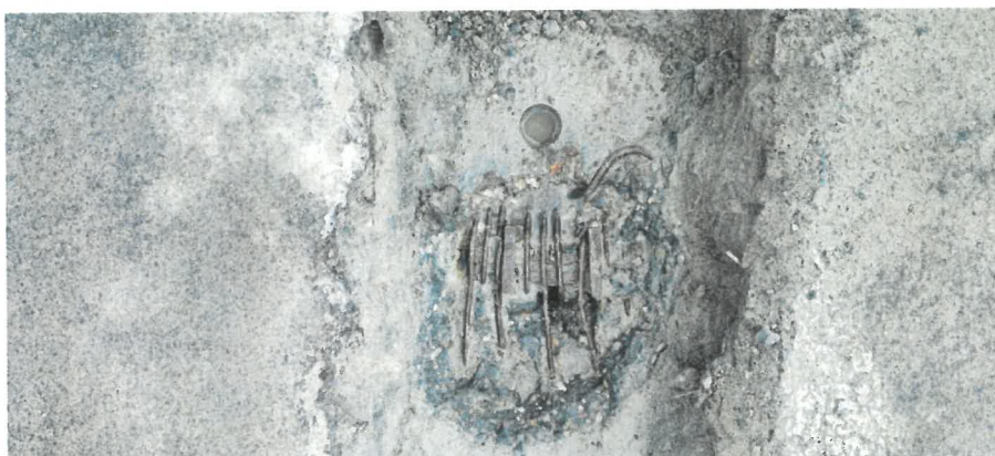
Obr. 18: Sekaná sonda SS3 u horního povrchu roznášecí hlavice sloupu stropní konstrukce. Sonda byla provedena po odbourání vozovkového souvrství parkoviště 2. NP.
