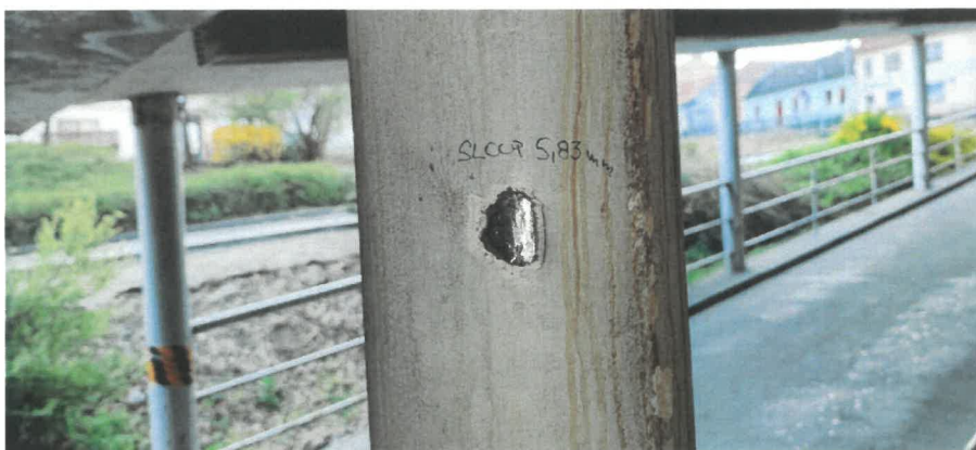
Obr. 25: Zkušební místo 4/C-1. NP – měření tloušťky ocelové trouby sloupu – 5,83 mm.
