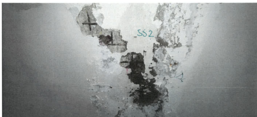
Obr. 15: Sekaná sonda SS2 ve spodním líci stropní desky parkoviště v úrovni 1. NP.
