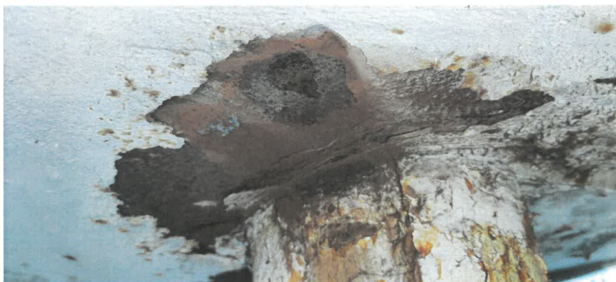
Obr. 29: Detail zkušebního místa 3/E-1. NP – měření tloušťky roznášecí desky pod předpjatou hlavici sloupu– 9,84 mm.
