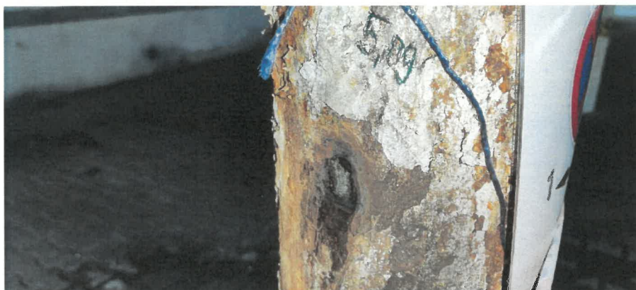
Obr. 26: Zkušební místo 4/D-1. NP – měření tloušťky ocelové trouby sloupu – 5,09 mm.
