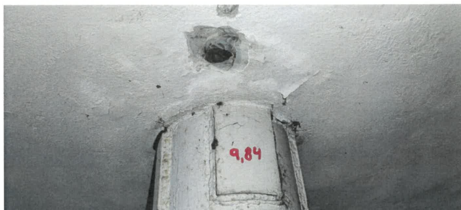
Obr. 27: Zkušební místo 3/E-1. NP – měření tloušťky roznášecí desky pod předpjatou hlavicí sloupu – 9,84 mm.
