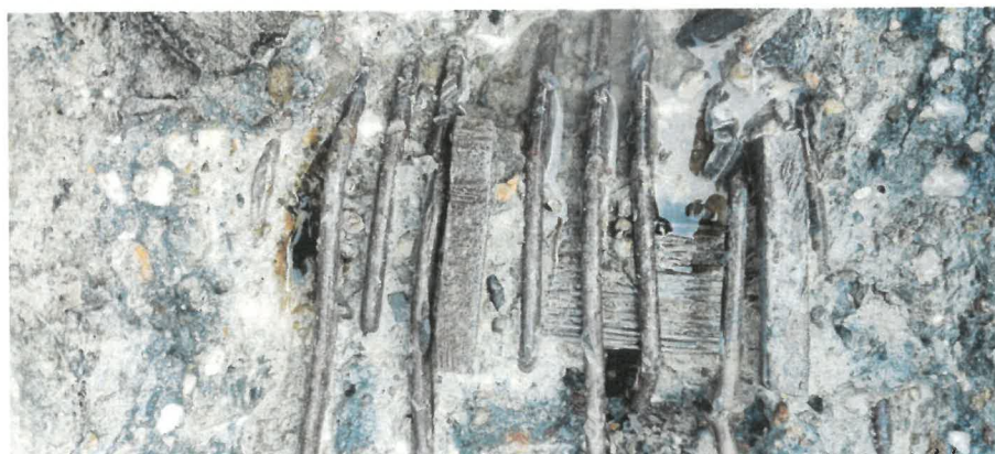
Obr. 19: Detail sekané sondy SS3 u horního povrchu roznášecí hlavice sloupu stropní konstrukce. Mezi pruty „měkké“ výztuže jsou kotevní desky, do kterých je opřený svazek předpínacích drátů.
