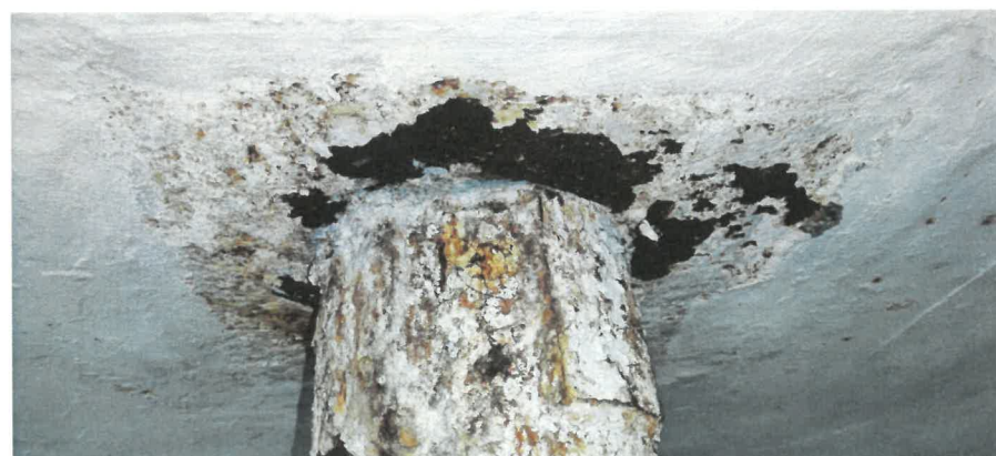
Obr. 24: Poškození roznášecí desky a trouby sloupu pod roznášecí hlavicí korozí, která je způsobená zatékáním agresivní vody kolem poškozeného odvodňovače.
